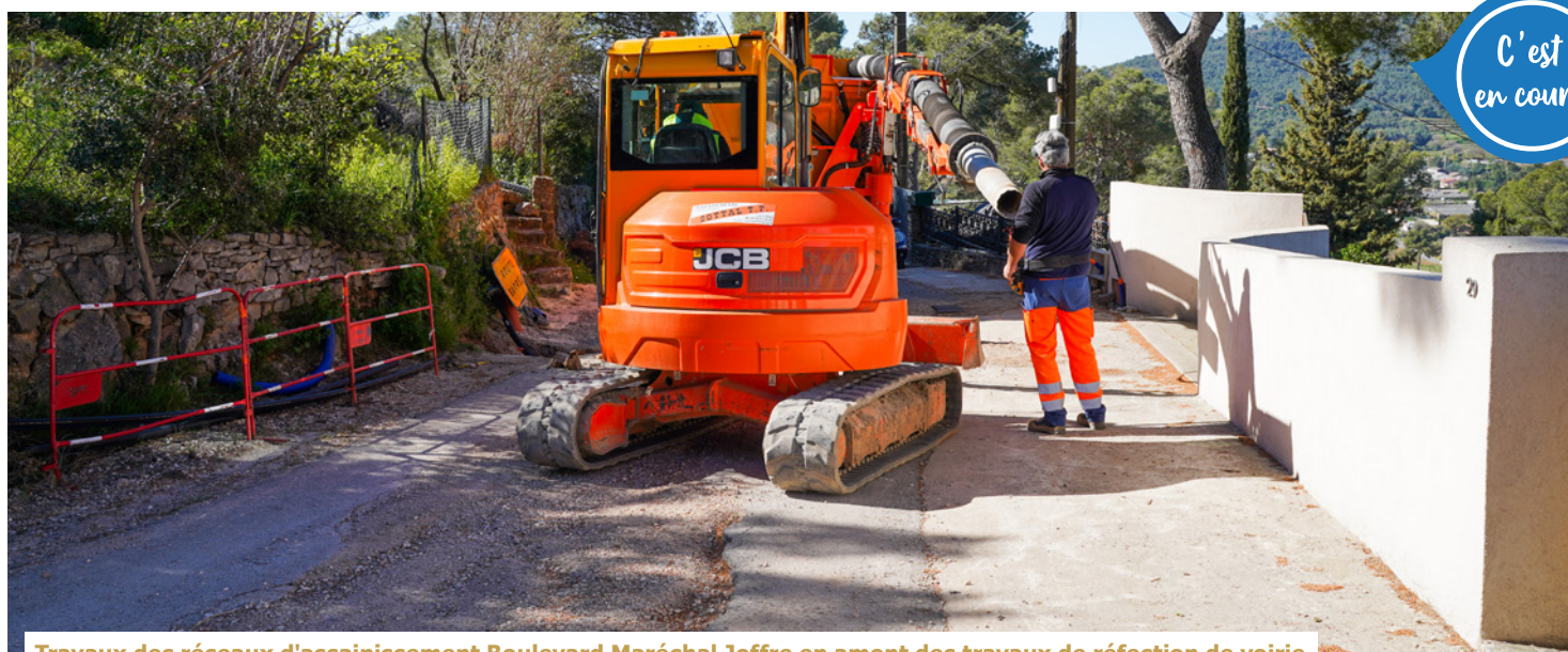
Travaux des réseaux d'assainissement Boulevard Maréchal Joffre en amont des travaux de réfection de voirie
