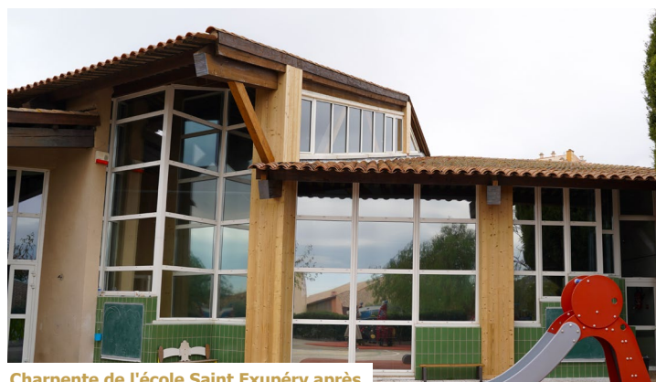
Charpente de l'école Saint Exupéry après
