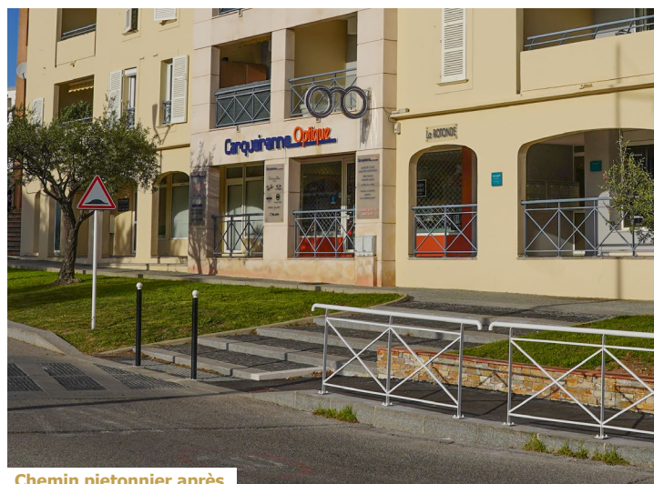
Chemin piétonnier après
