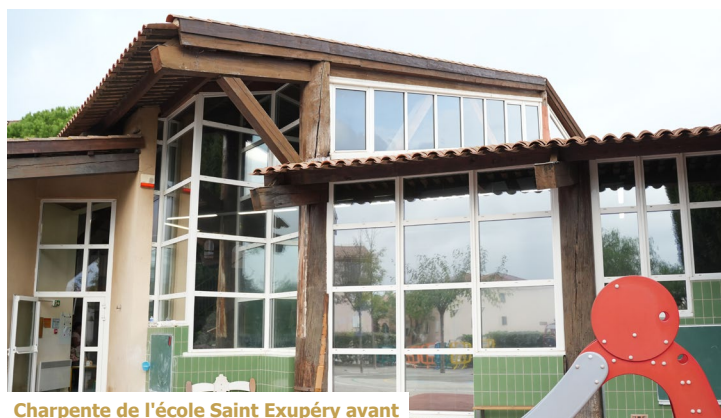
Charpente de l'école Saint Exupéry avant
